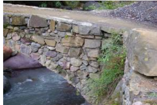
图四 附近桥梁一角
