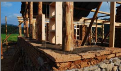
现正进行墙体结构工程
