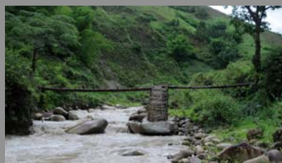
咪霞村原有桥梁
